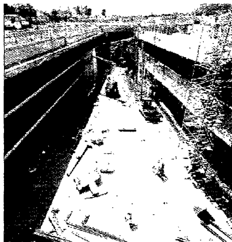
Il cantiere della Metro C di via Teano, dove si sta realizzando una stazione che servirà la nuova linea
