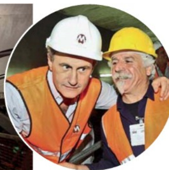
Il sopralluogo Ieri, l'ultima visita al cantiere di piazza Annibaliano da parte del sindaco Alemanno e dell'assessore Aurigemma
