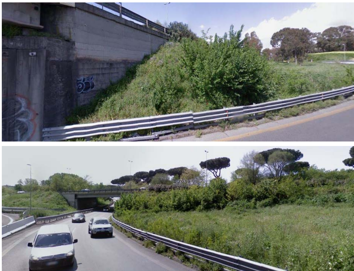
Figura 3-14: AREA NORD – Stato della vegetazione ad aprile 2008 (nella foto in alto è visibile il rilevato di via Pontina in prossimità del sovrappasso della Colombo; nella foto in basso è visibile il margine nord di via Colombo dir. Eur, privo di vegetazione)
