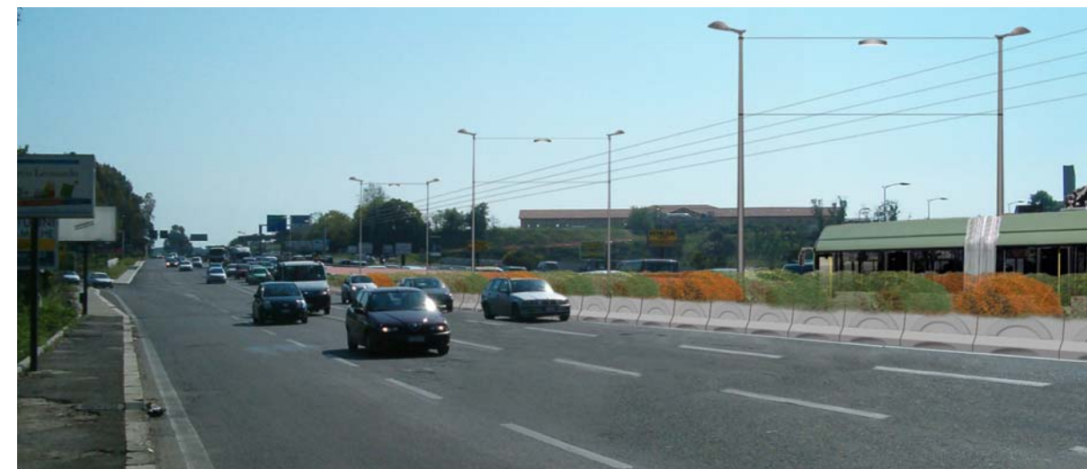
Figura 3-5: Vista del casale trp_0626 da via C. Colombo - POST OPERAM
