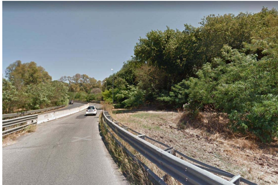
Figura 3-11: AREA BOSCATI SUD (a destra nella foto) - Vista dall'attuale rampa di immissione Pontina-Levi
