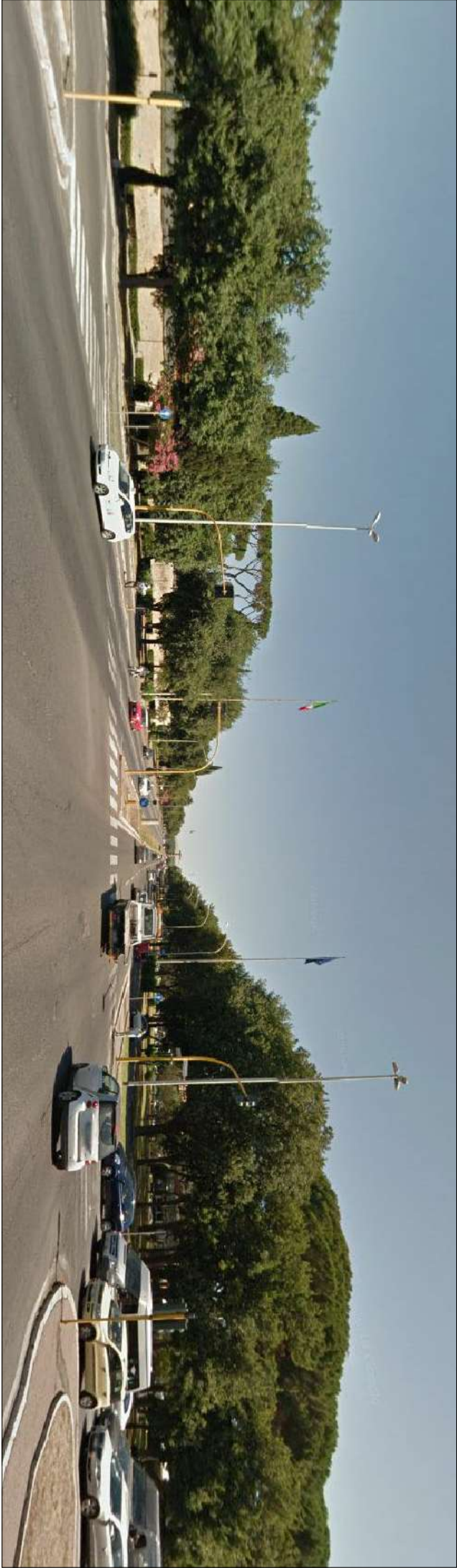
Foto 48 Svincolo Colombo-Oceani. Nel tratto compreso tra lo svincolo Colombo-Pontina e piazzale P.L. Nervi, la sede filovaria è prevista al centro della carreggiata di via C. Colombo. Tale inserimento avviene riducendo la larghezza dello spartitraffico attualmente esistente al centro della Colombo. All'interno della nuova aiuola saranno posizionati i pali TE con mensole disposte simmetricamente rispetto al palo. In prossimità di piazzale XXV marzo 1957 sono previsti ridotti interventi di riprofilatura dei cigli esistenti.
