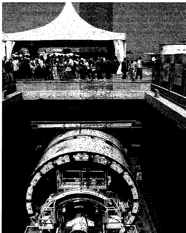
LINEA C Una delle quattro «talpe» che stanno scavando i tunnel della metro
