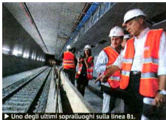
► Uno degli ultimi sopralluoghi sulla linea B1.
