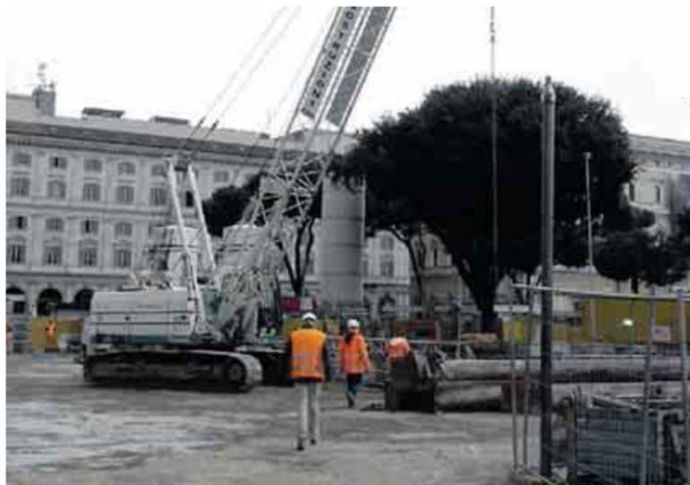
Il cantiere dei lavori in piazza dei Cinquecento
