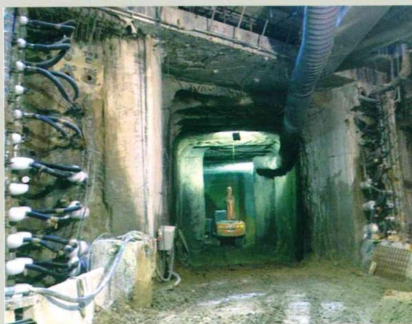
La metodologia indiretta è caratterizzata da una minore potenza frigorifera e da un impianto tecnologicamente complesso: si hanno quindi generalmente tempi di congelamento più lunghi e una minor applicabilità in presenza di acqua in movimento. Il metodo diretto o ad "azoto liquido" è caratterizzato da una potenza frigorifera nettamente più elevata e da un impianto di notevole semplicità; si hanno
