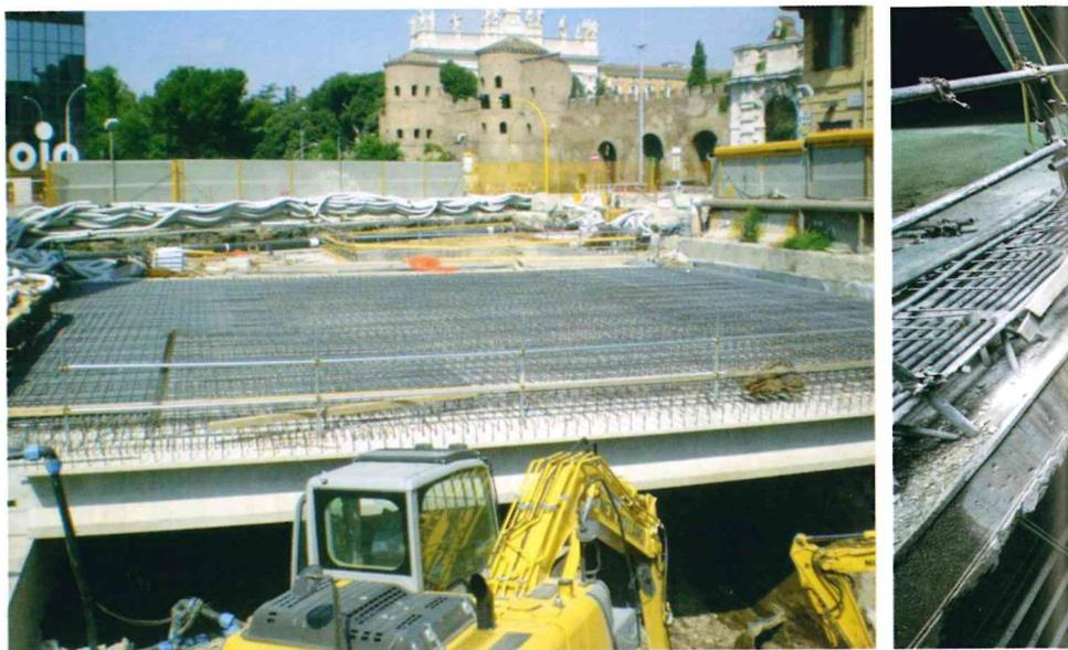
Solaio di copertura - trave prefabbricata in cemento armato
