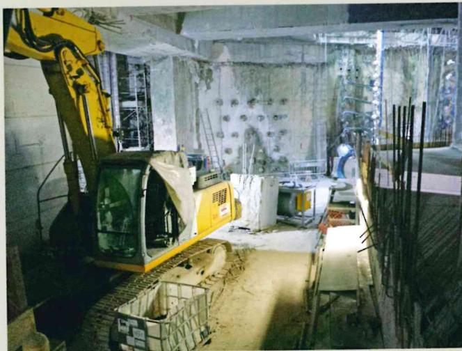
sta la presenza della stazione esistente e soprattutto vista la natura dei terreni da scavare che, per circa 2/3 della sezione della galleria hanno una natura granulare con forte presenza di sabbie e ghiaie e permeabilità piuttosto elevata dell'ordine di 10-4 m/s. Lo scavo sarà eseguito dal profondo pozzo dalla stazione della Linea C previa esecuzione del congelamento, per il quale sono previste perforazioni guidate propedeutiche all'installazione di sonde congelatrici e sonde termometri-
